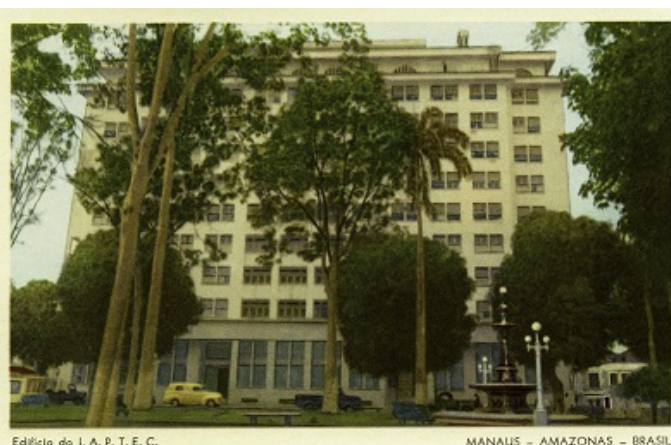
02. Aspecto primitivo do imóvel. Fonte: EDIFÍCIO, [195-?]. Edifício do I. A. P. T. E. C. MANAUS - AMAZONAS - BRASIL
